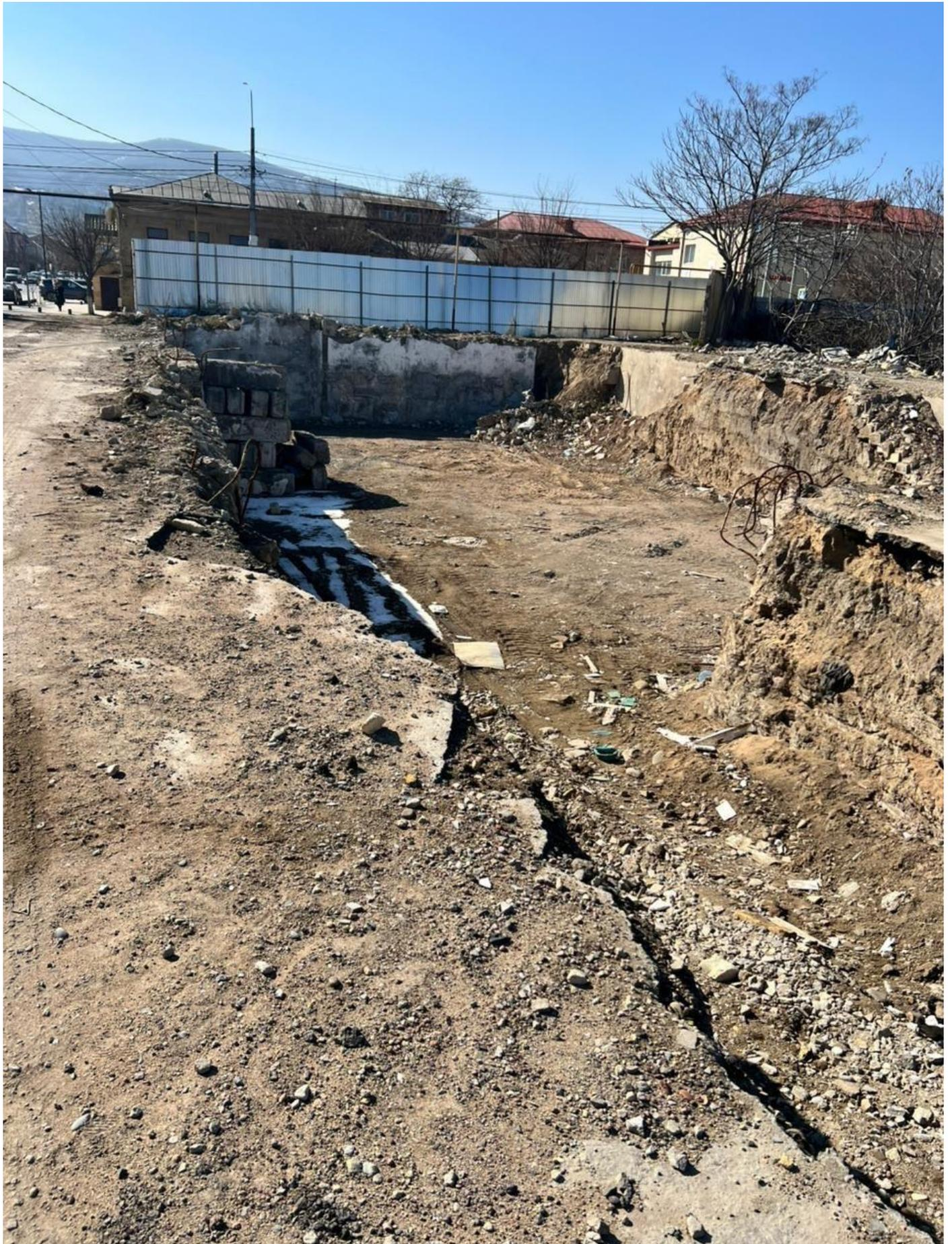
*Фото 3. Общий вид котлована демонтированного промышленного здания, расположенного на рассматриваемом земельном участке и примыкающему к месту строительства подземной парковки в запада*
